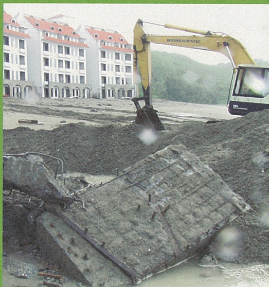
2007/8/18 強颱聖帕首次將美麗灣渡假村掩埋於沙灘的大型鋼筋混凝土沖刷出來。
